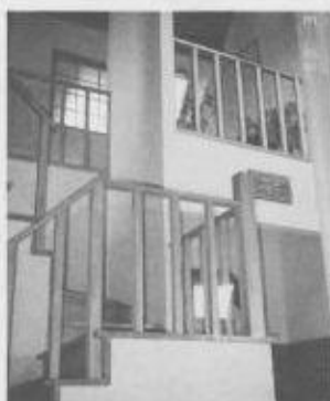
ホール、階段 (2F窓下部がキッチン)
